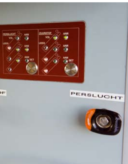
stelsel voor perslucht en zuurstof.
